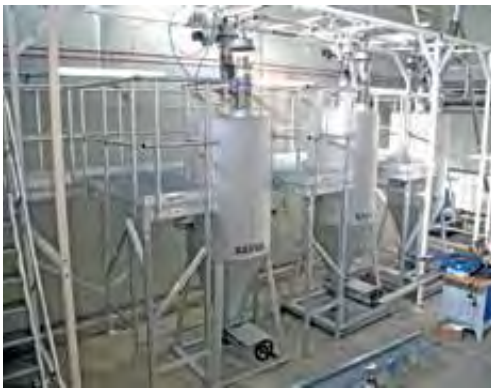
Fachmännische Konstruktionen mit genauen Konturanpassungen für gefahrloses Arbeiten in der Höhe
