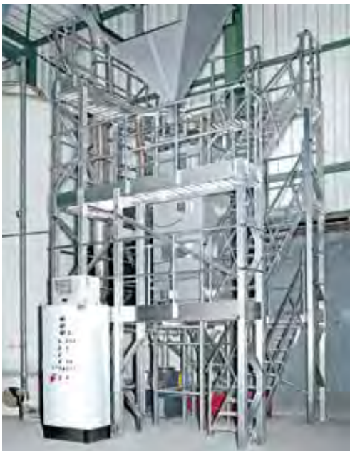
Zuverlässige Einrüstungen ermöglichen den sicheren Zugang zu unwegsamen Anlagen
